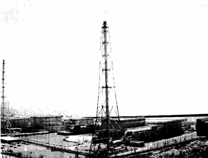
◀原子力発電所風景 中央は排気筒
